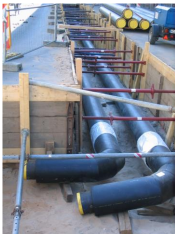
Fernwärme kanalverlegte Leitung, T > 100\text{ °C}
