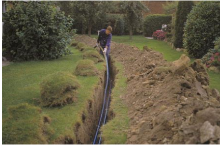
Verlegung einer flexiblen Leitung als Hausanschluss
